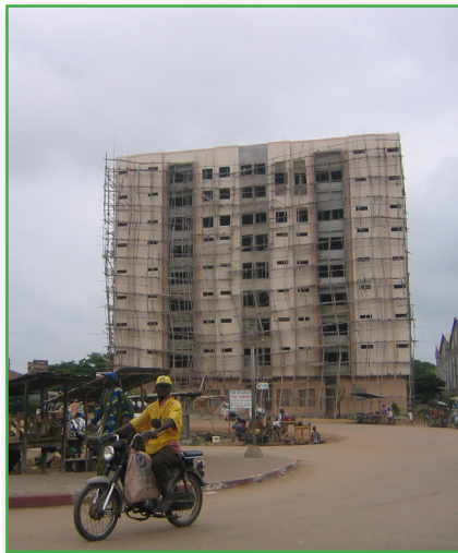
Bâtiment en construction. Cotonou
